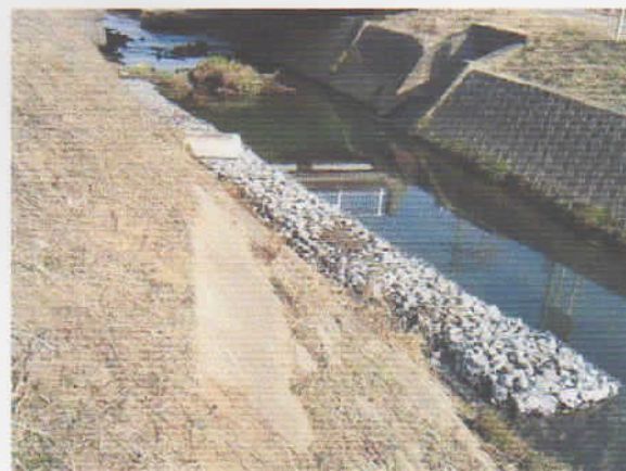
図3 施工中の様子（2004. 2. 19）
